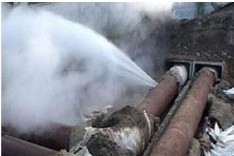
Рис. 6.1. Разрыв трубопровода высокого давления
