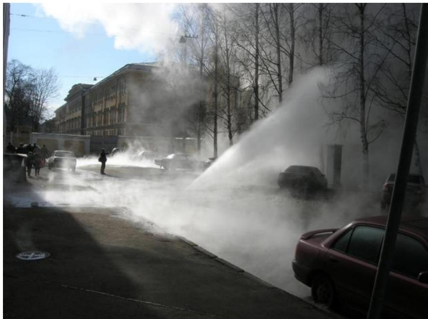
Рис. 6.6. Прорыв трубопровода на теплотрассе высокого давления
